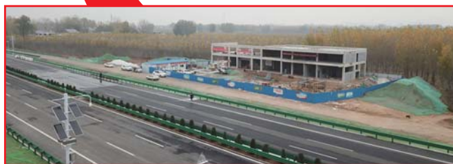
国道220长清绕城段正在建设中的停车区。 本报记者 刘飞跃 摄
