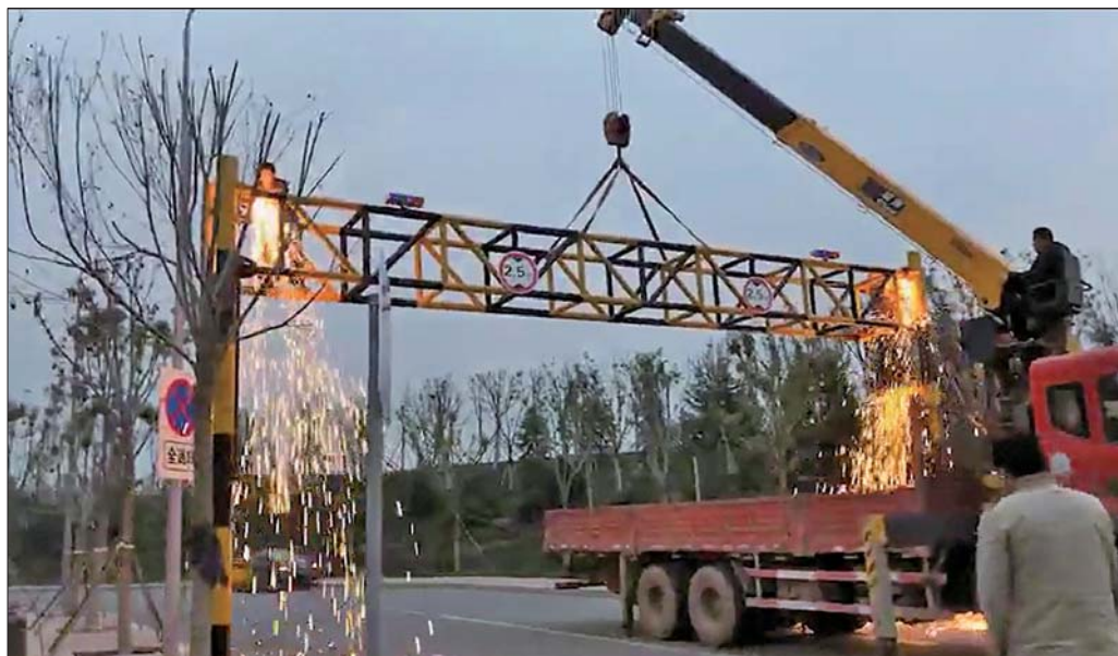
和润幸福花园小区南侧,未达到消防高度限制的限高杆已被拆除。居民供图
