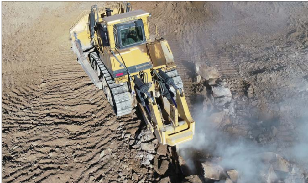
山推机械在施工现场。
