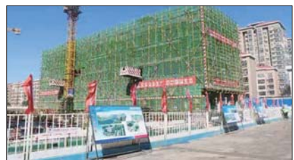
11月16日,中西古城棚改项目首栋回迁房2#楼率先封顶。通讯员供图
