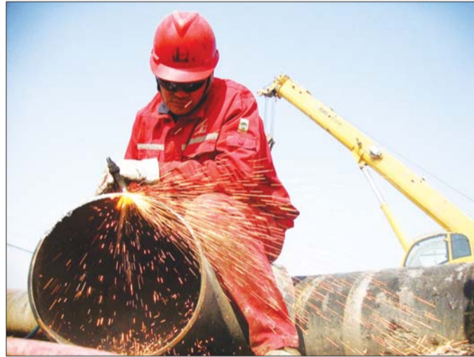
员工正在更换管线。
