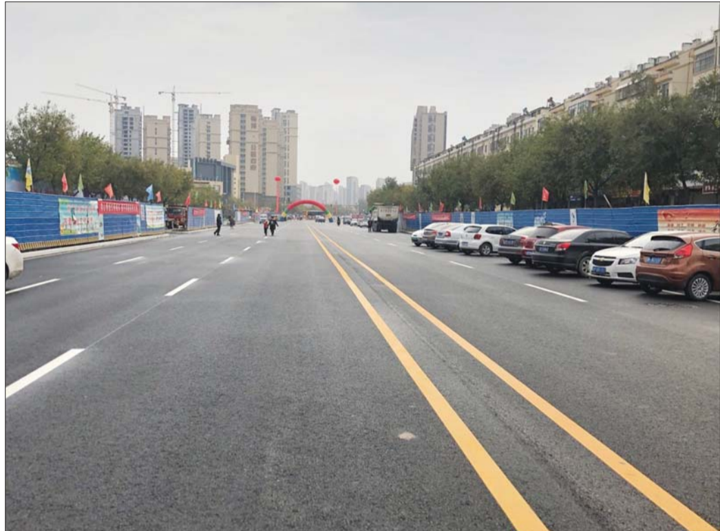
经过近八个月施工改造,后菜市街以全新面貌展现在市民面前。
