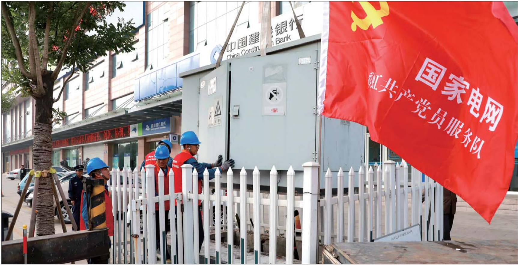
国网济宁供电公司供电人员改造10千伏吴泰 I 线3号分支箱。
