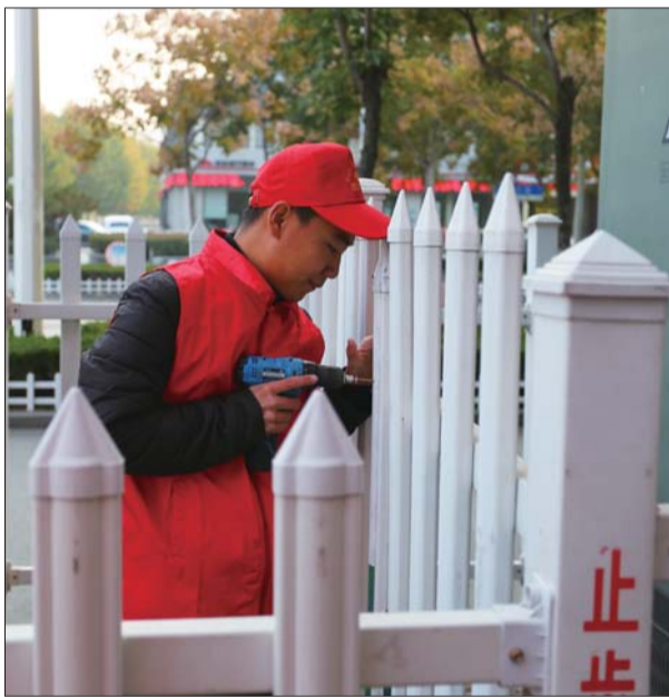
配电运检人员修复城区内环网柜损毁围栏。
