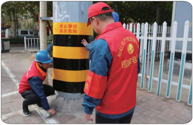
供电员工更换电力设施警示标识。
