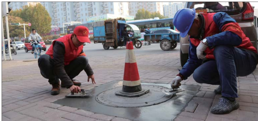
供电人员对城区内电力设施进行整修。
