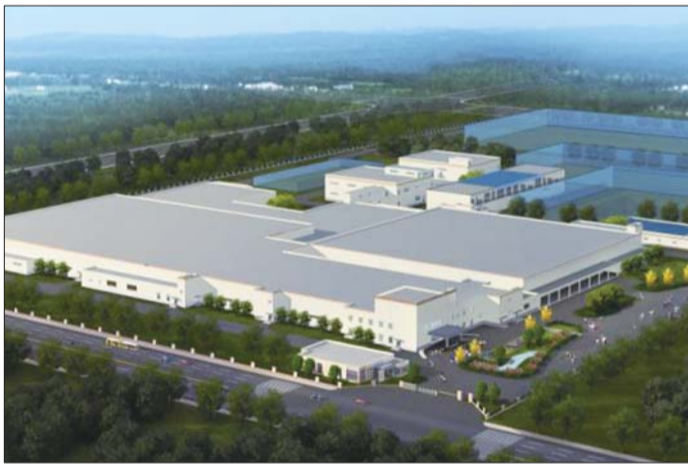
海富电子功能材料电子模组项目。
