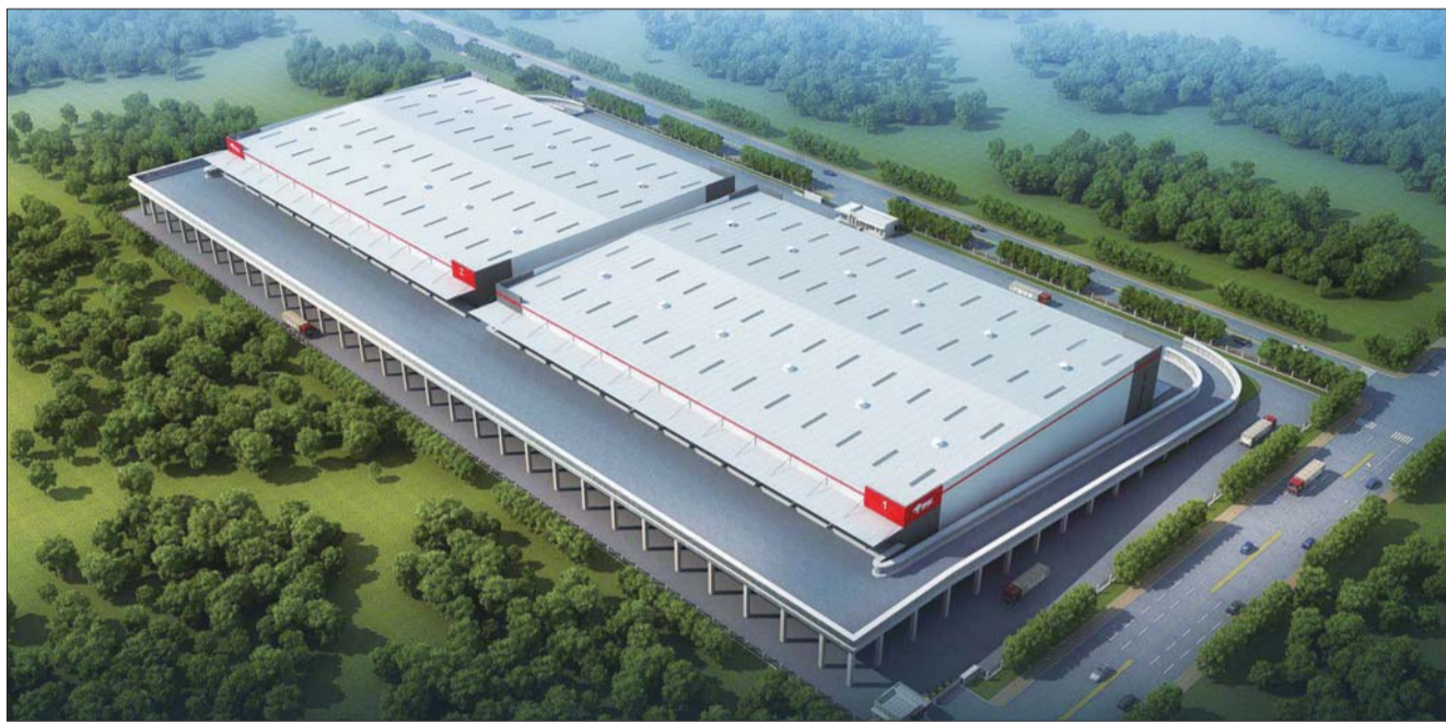
京东集团济宁“亚洲一号”项目。
