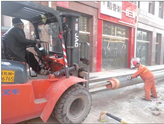
金色家园门口热力施工人员正运走管道。
