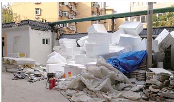
制锦市街1号院内堆放了大量水泥、泡沫板等保温材料。
