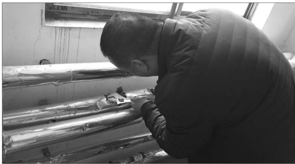
维修人员正在关闭暖气进户总阀,疏通暖气片里的堵塞物。 本报记者 周惠娇 摄
