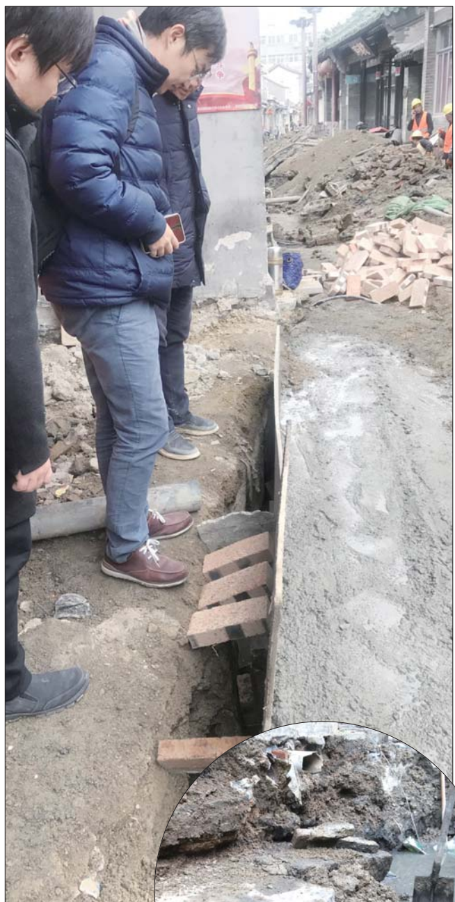
▲从20多厘米的施工缝隙能看到整齐的石板壁。
