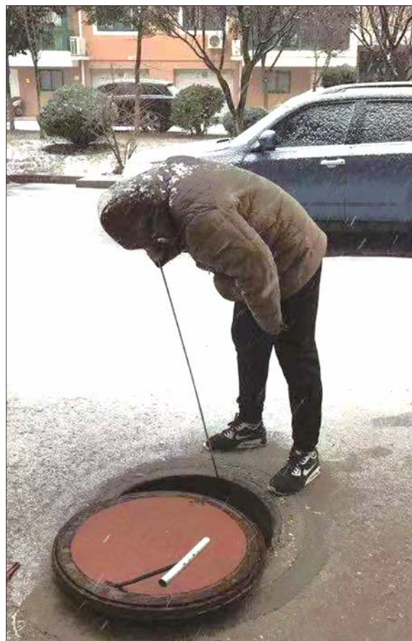
500供热工作人员冒雪查漏。
