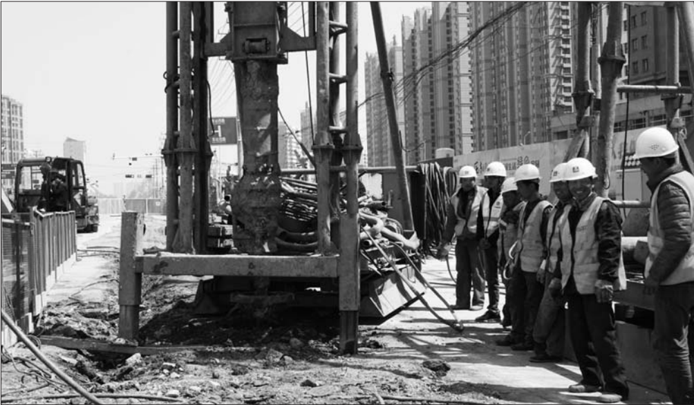
车站西路综合管廊工程首根钻孔灌注桩。 本报记者 周惠娇 摄
