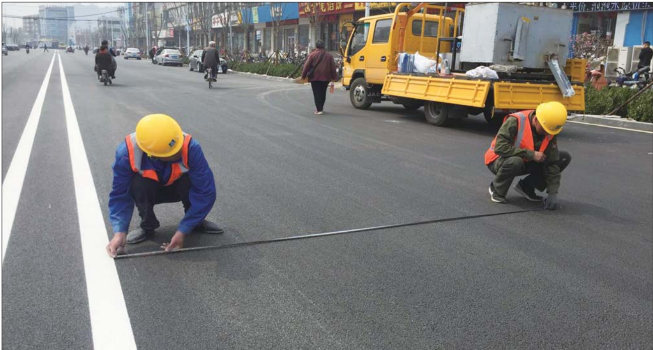
施工人员进行道路标线测量。 本报记者 周惠娇 摄
