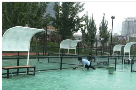
▲乒乓球硅PU面层正在施工。
