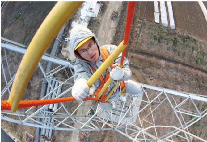
李敏在500千伏输电电路上开展等电位带电作业。 通讯员 徐可 摄
