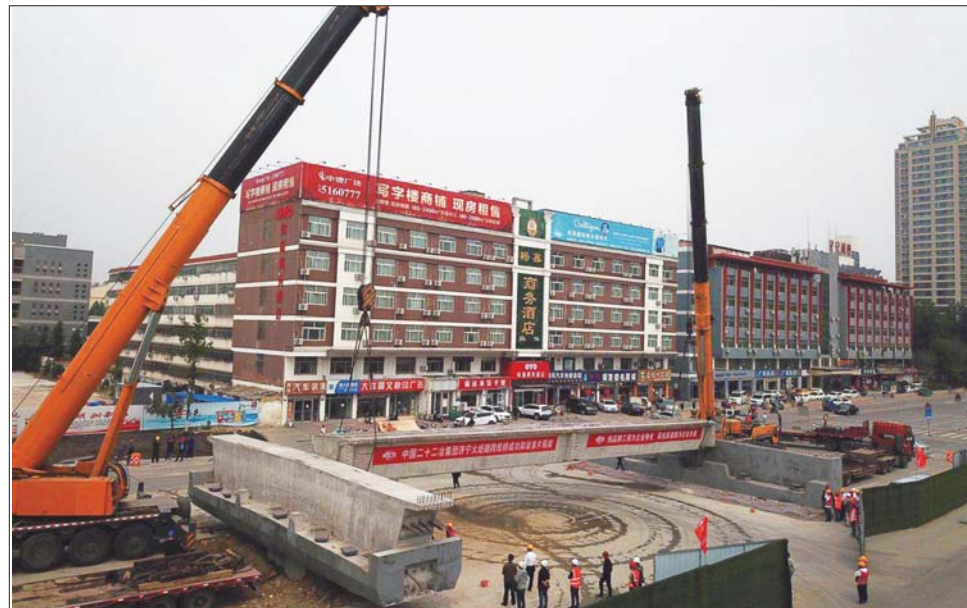
首片预制箱梁平稳安放在火炬路跨线桥的桥墩上。 本报记者 周惠娇 摄
