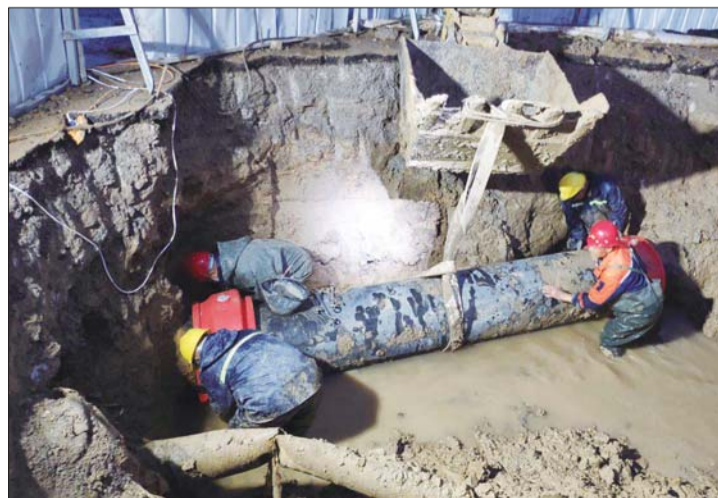
供水维修人员正在连夜抢修破损管道。
