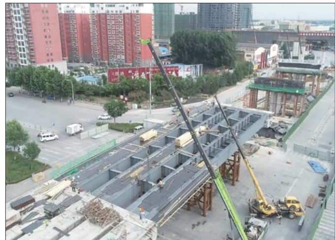
火炬路跨线桥已经显现雏形。 本报见习记者 梁响 摄
