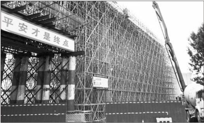
连续梁混凝土浇筑现场。
