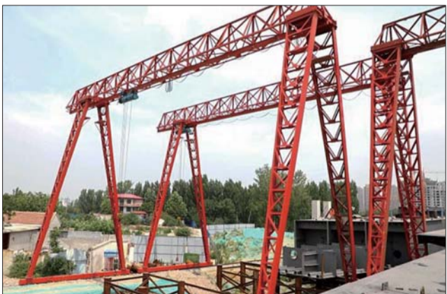
车站南路跨老运河桥梁工程施工现场。
