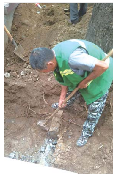
园林工人在给古树换土，里面埋着一些水泥板。
