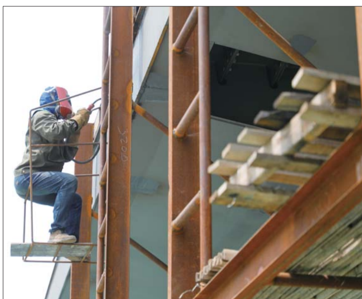
工人正在桥上进行焊接作业。 本报记者 李岩松 摄
