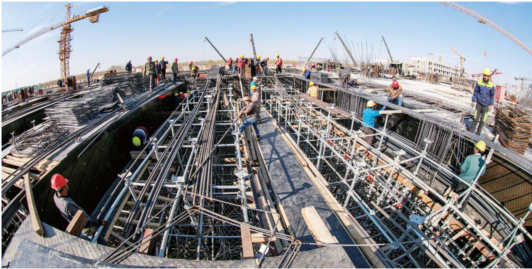
济南东车辆段施工一标主体结构施工,千人大会战施工场面。
