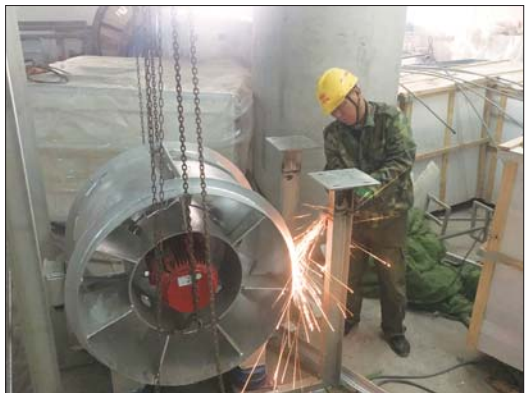
丁家东车站内，工人正进行风机吊架加工。
