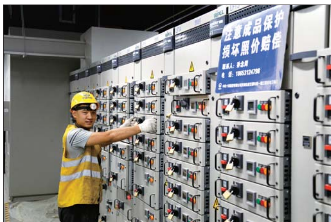
工人进行环控机房设备调试。
