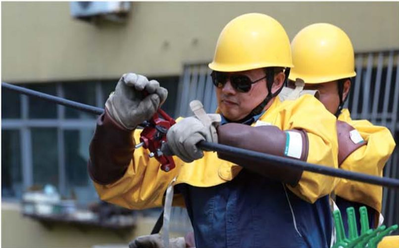
带电剥除导线绝缘皮。
