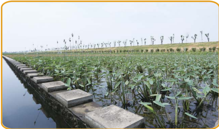
湿地内的潜流池,可以净化企业排出的中水。
