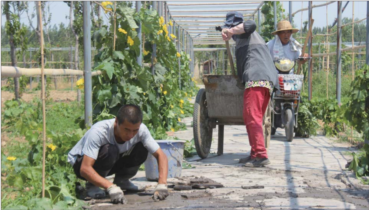
营地道路均已铺设完毕。
