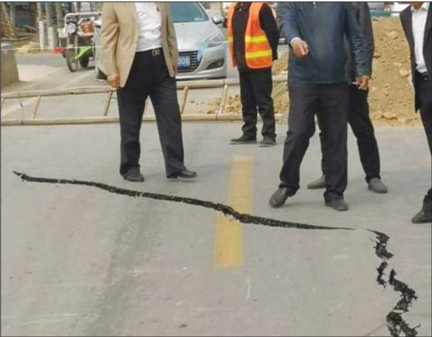
桥面发生塌陷断裂。
