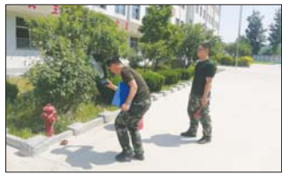
沂源县三岔中心学校对消防设施进行检查维护。(亓和田)
