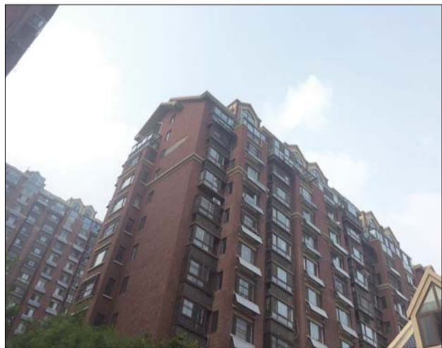
人文嘉园小区居民楼出现多处外墙脱落。
