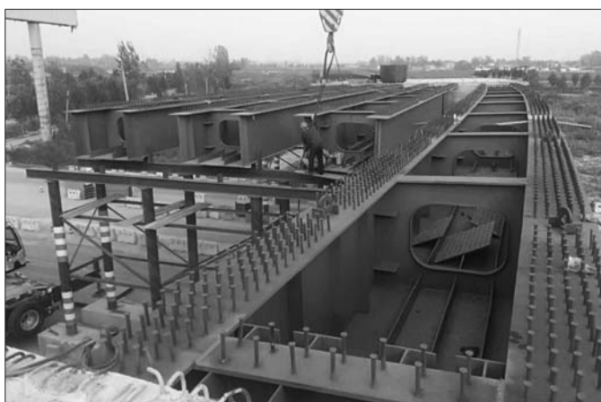
钢箱梁架设现场。
