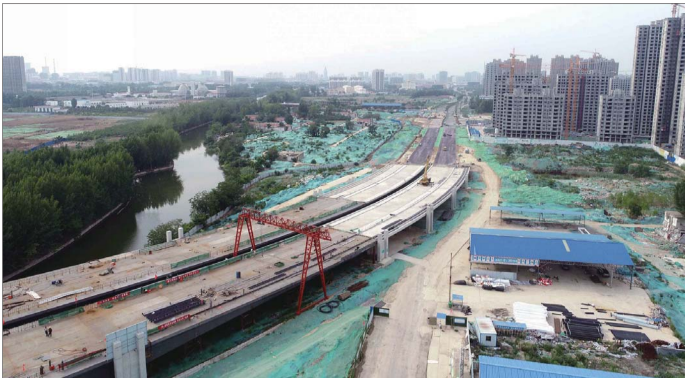
车站南路跨运河桥项目施工现场(资料图)。
