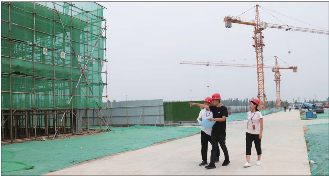
工作人员正在查看项目建设情况。
