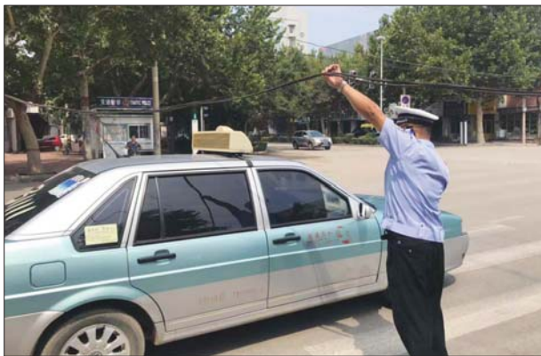
交警杜向彬用手举起脱落的线缆。
