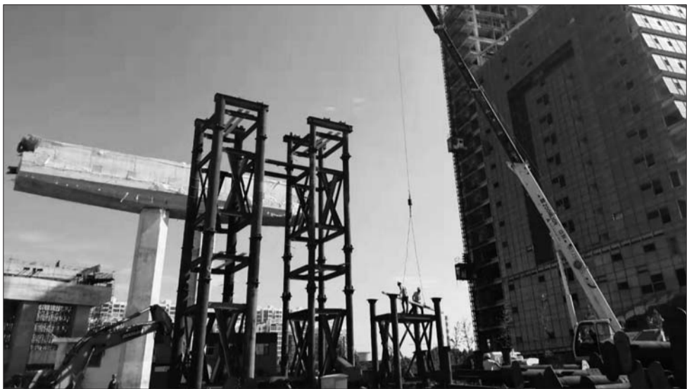
火炬路跨线桥施工现场。齐鲁晚报·齐鲁壹点记者 周惠娇 摄
