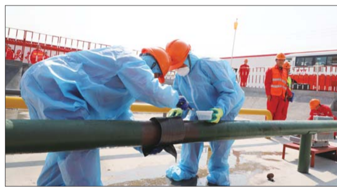
引进绿色维修新技术,提高施工质量。
