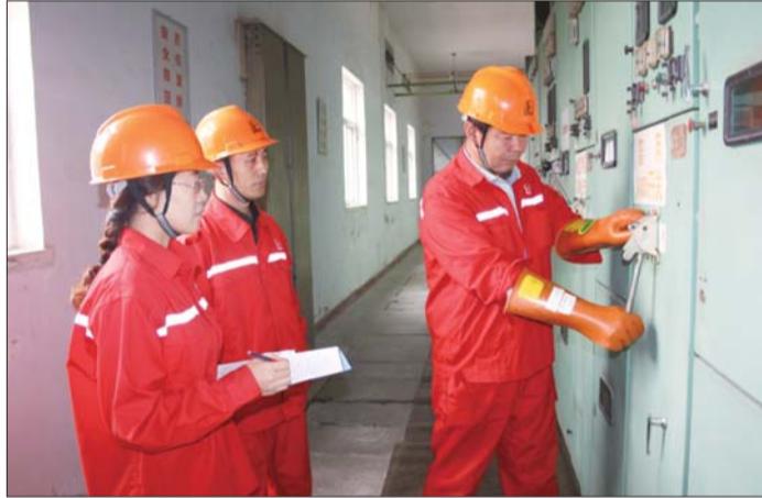
南区供电公司变电工作一站在龙居变电网检修中进行模拟演练。通讯员 安小莉 摄
