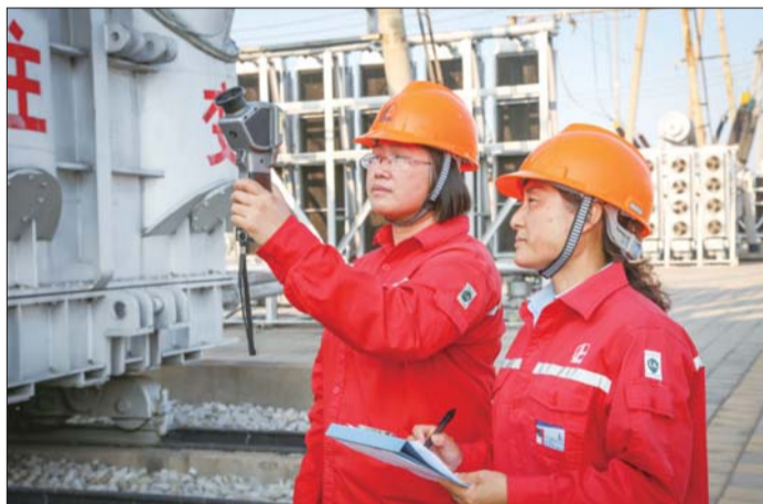
220千伏九分场变电站职工正在用热成像测温仪对主变进行测温。通讯员 王云 摄
