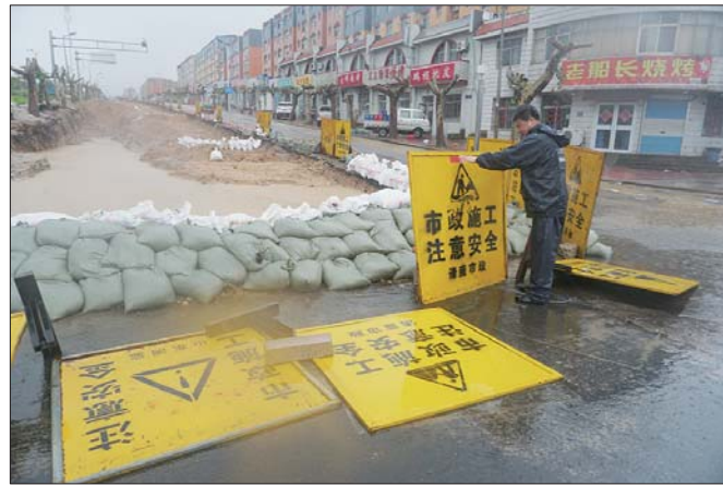
工作人员正在处理汕头路道路施工现场积水问题。 通讯员 曲蕾 摄影报道
