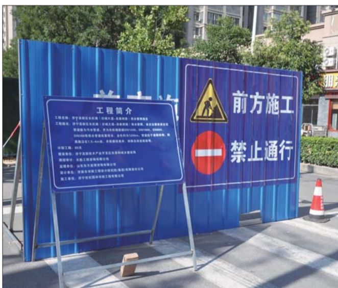
雨污分流改造施工现场。本报记者 孔茜 摄
