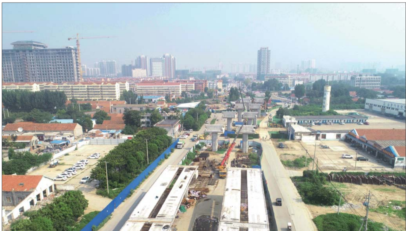
王母阁路跨线桥第一批箱梁已经架设完成。齐鲁晚报·齐鲁壹点记者 孙逢辉 摄
