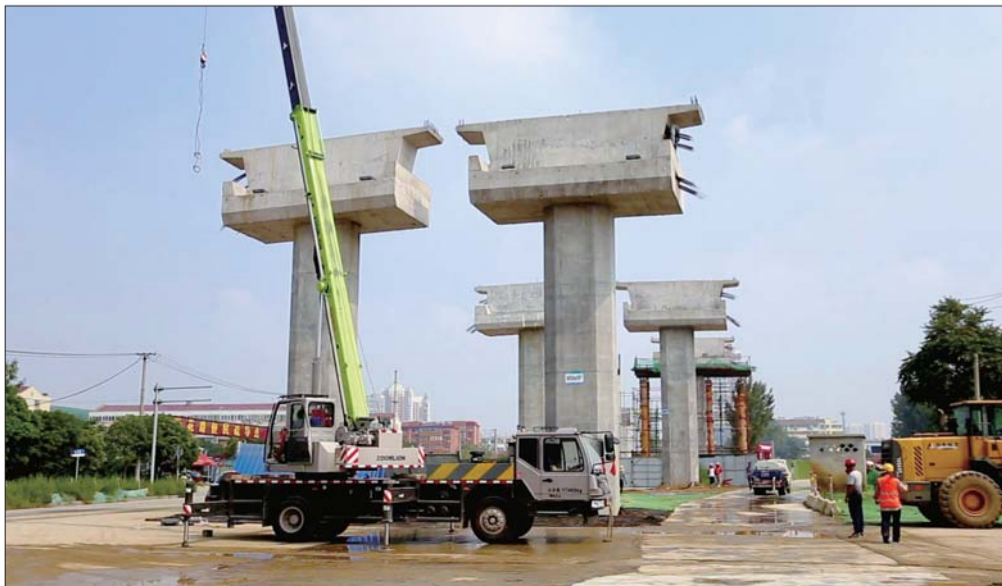
项目施工现场。齐鲁晚报·齐鲁壹点记者 孙逢辉 摄
