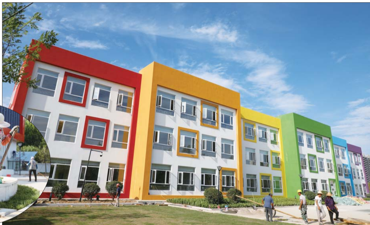
济宁市机关幼儿园(太白湖新园)即将竣工。
