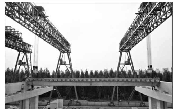
济宁内环高架工程首片梁成功架设。
