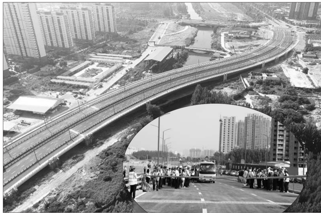
车站南路跨老运河桥正式通车。
