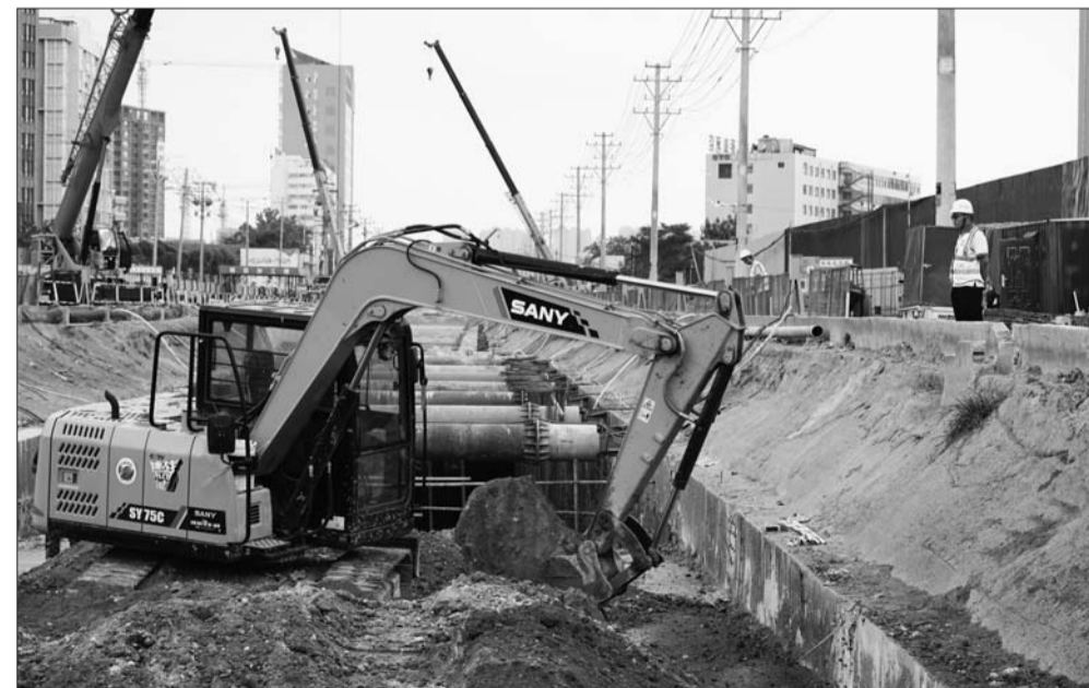
施工方正在进行土方回填作业。
