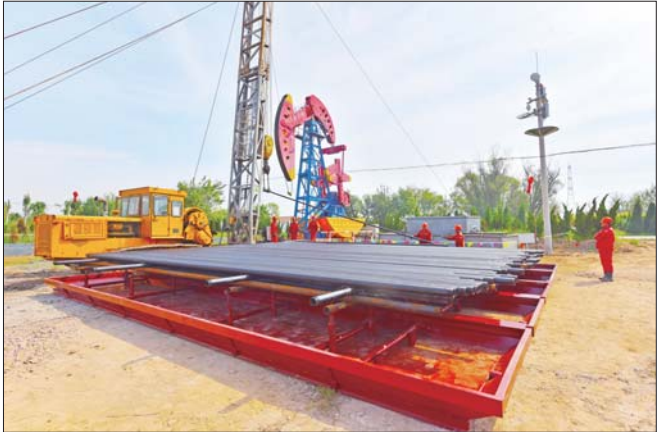
河口厂要求作业承包商使用环保新围堰。 通讯员 吴木水 摄
