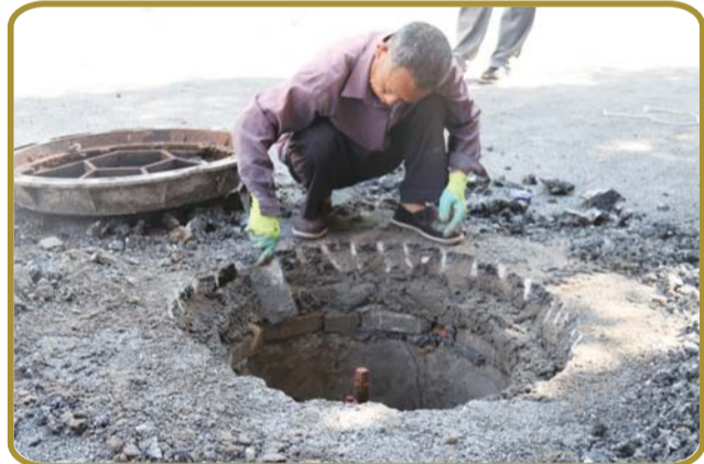
维修路面井盖。
