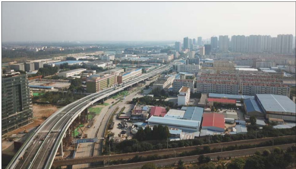
火炬路跨线桥即将通车。
