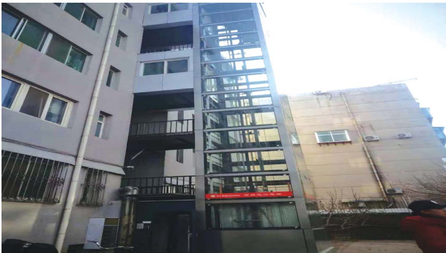
山大路85号利农花园西区正在进行老旧小区加装电梯改造。
