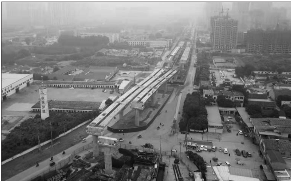
王母阁路跨线桥施工现场。
